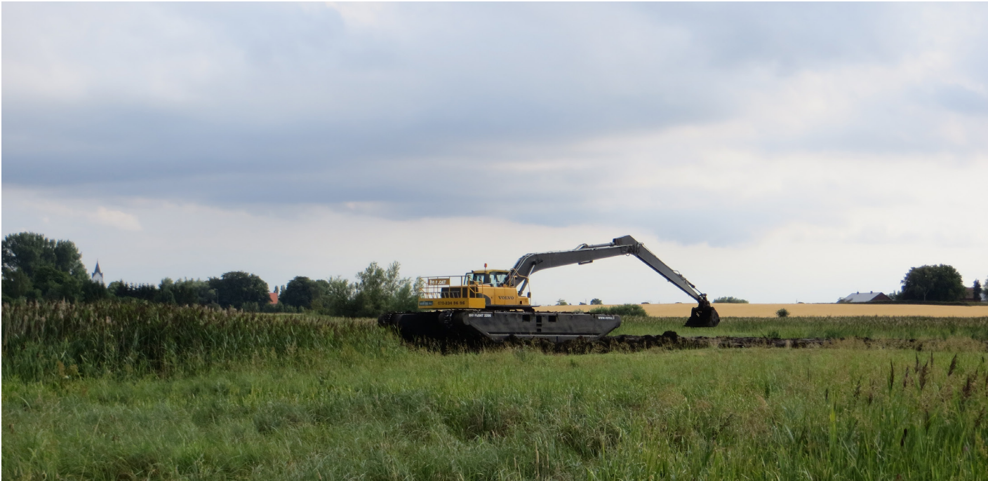
Pontongrävmaskin för att minska markkompaktering vid schaktarbete i våtmarksmiljö. Bild Ekologigruppen
